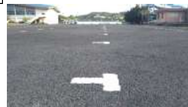
（総合グラウンド駐車場枠塗装）
